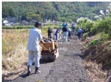
未舗装農道の舗装
