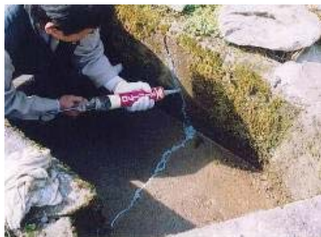
水路のひび割れ補修
