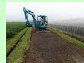
農道の復旧状況
