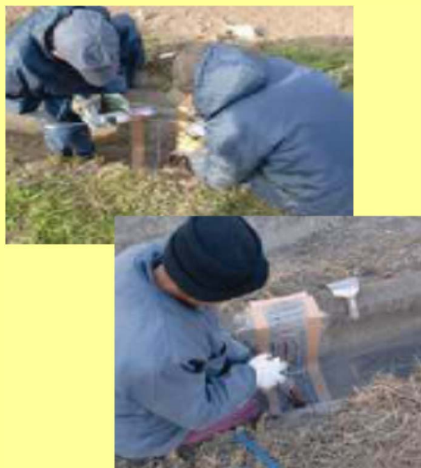
【地域住民による目地詰めの様子】
