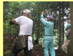
獣害柵の補修管理
