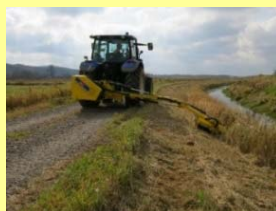
排水路法面の草刈
