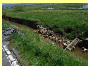
水路及び農道の破損状況
