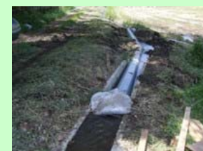
仮設配管の敷設状況
