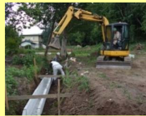
自主施工の実施
