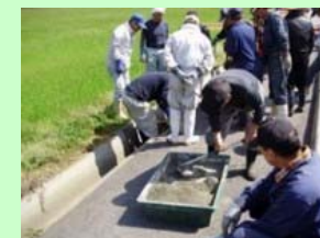
目地詰め作業
