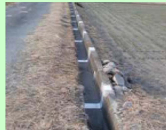
【目地詰め補修完了後の水路】
