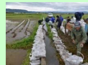
土のうの積み上げ作業
