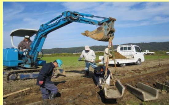
自主施工による水路の布設替え
