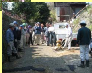
農道の簡易補修
