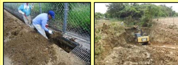
側溝や浸透池の泥上げ
