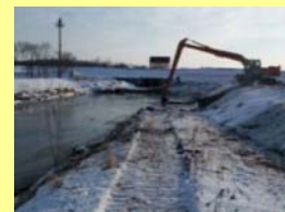
沈砂池の泥上げ (3年に1回(沈砂池数7))
