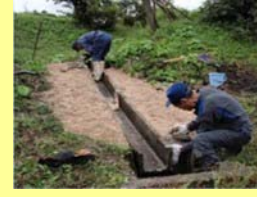
直営施工(水路の補修)
