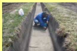
水路の目地補修
