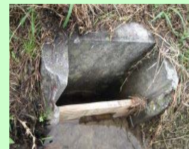
堰板による田んぼダム
