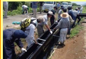
水田魚道の設置
