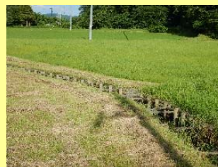
景観に配慮した木柵水路
