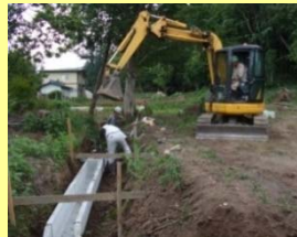
自主施工の実施
