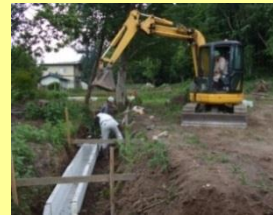
自主施工の実施
