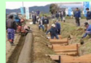
集落総出で魚道を設置
