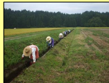
水路の泥上げ
