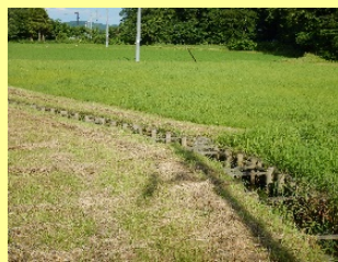
景観に配慮した木柵水路
