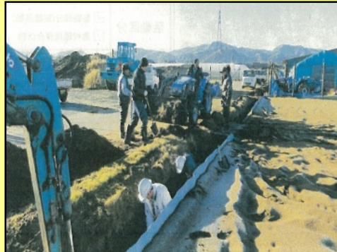
水路の泥上げ
