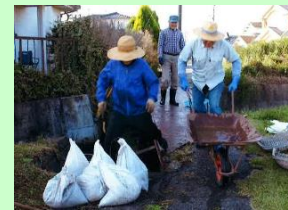
水路の泥上げ
