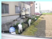
水路の泥上げ
