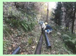
配水パイプの設置
