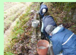
開水路の水漏箇所を目地詰め
