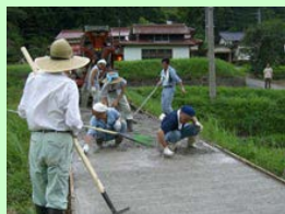
農道のコンクリート舗装
