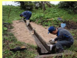
直営施工（水路の補修）
