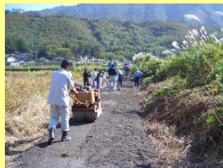
廃アスファルトで農道舗装。
