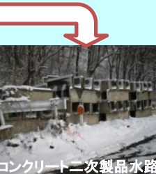
コンクリート二次製品水路
