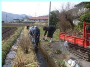
水路泥上げの様子
