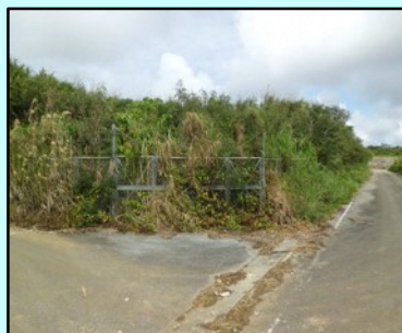
作業前の浸透池
