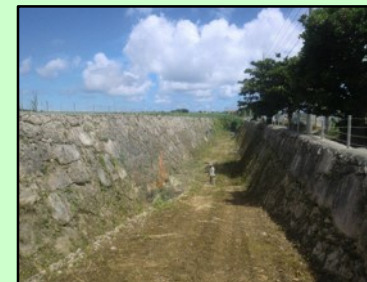
作業後の浸透池
