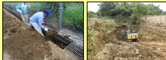
側溝や浸透池の泥上げ
