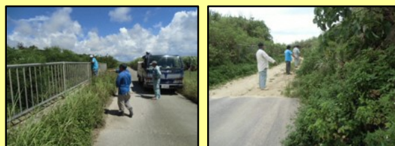
組織による施設の点検
