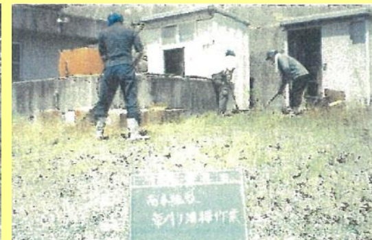
揚水施設周辺の草刈り、給水栓への凍結防止の保温材投入
