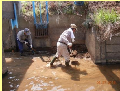
取水ゲート前の泥上げ
