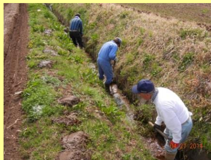
水路の泥上げ
