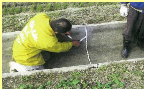
水路の目地詰め（直営施工）
