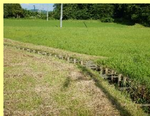
景観に配慮した木柵水路
