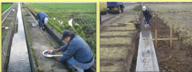
自主施工による目地補修
