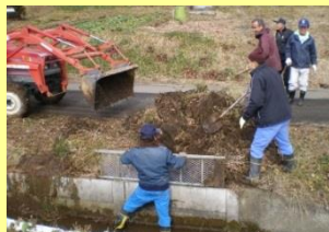
（水路側壁の補修）
