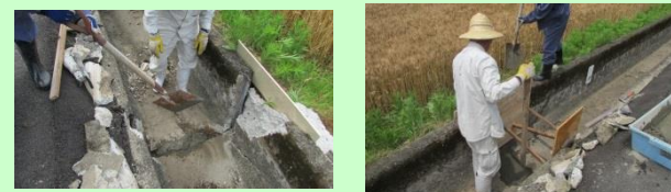
大きな破損箇所も、ベニヤ板の型枠を使って補修
