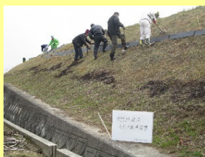
ため池法面での小段設置
