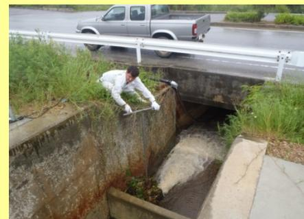
豪雨前にため池の水を抜き、水位調整のためゲート操作を実施
