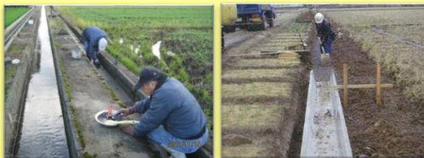
自主施工による目地補修
