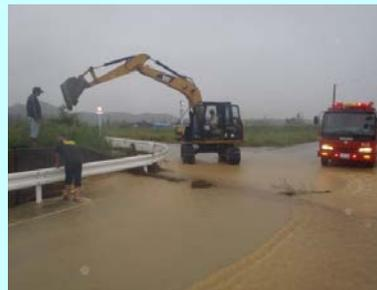
湛水確認後、応急措置として土砂除去を実施
