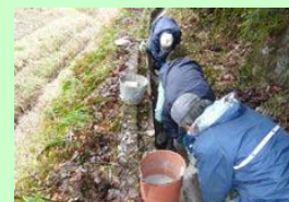
開水路の水漏箇所を目地詰め
