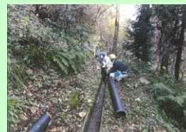
配水パイプの設置
