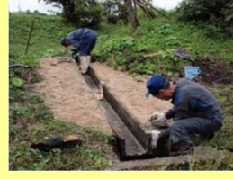
直営施工（水路の補修）
