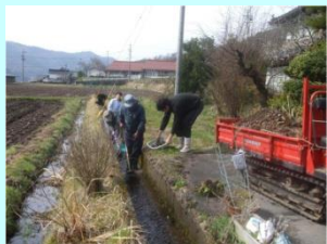
水路泥上げの様子
