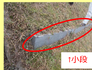
ため池法面に設置した小段
