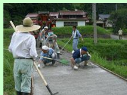
農道のコンクリート舗装
