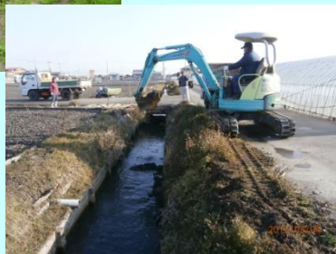
排水路の泥上げ
