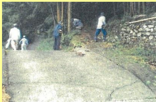
農道の点検、草刈り、側溝清掃
