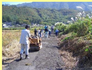
廃アスファルトで農道舗装。
