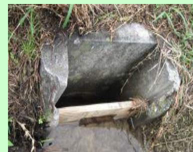
堰板による田んぼダム
