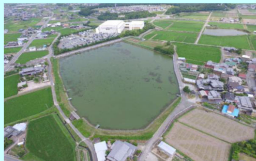
ため池の全景
