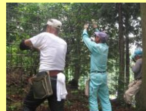
獣害柵の補修管理
