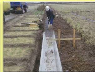
二次製品水路敷設
