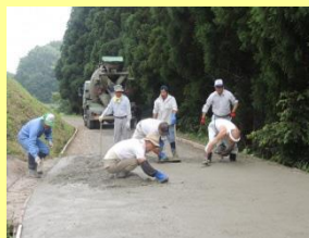
直営施工による農道舗装
