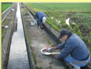
自主施工による目地補修
