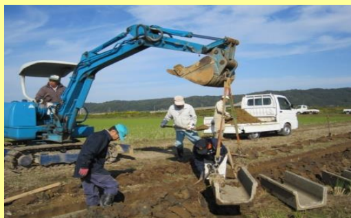
自主施工による水路の布設替え
