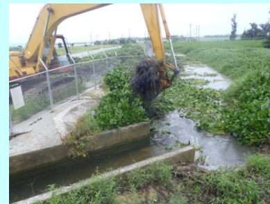
湛水未然防止のため土砂さらい
