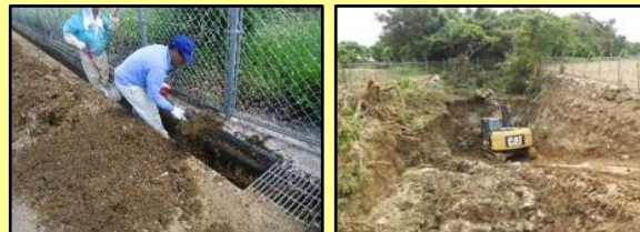
側溝や浸透池の泥上げ
