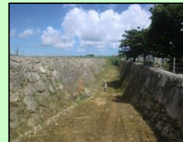
作業後の浸透池
