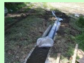
仮設配管の敷設状況
