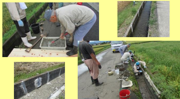
慣れた手つきでコンクリート練りから目地補修まで
