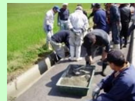
目地詰め作業
