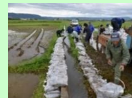
土のうの積み上げ作業
