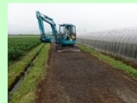
農道の復旧状況
