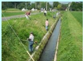
水路法面の草刈り
