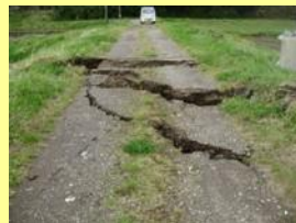
水路及び農道の破損状況
