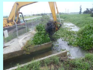
湛水未然防止のため土砂さらい
