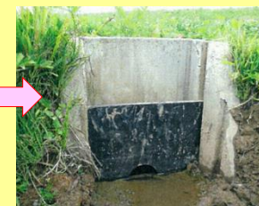
水戸板設置状況
