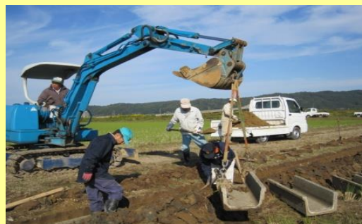
自主施工による水路の布設替え
