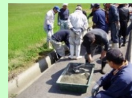
目地詰め作業
