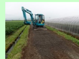
農道の復旧状況
