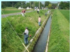
水路法面の草刈り
