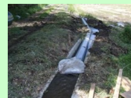
仮設配管の敷設状況
