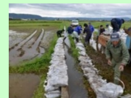
土のうの積み上げ作業
