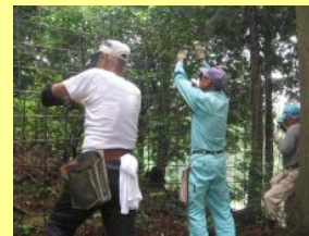
獣害柵の補修管理
