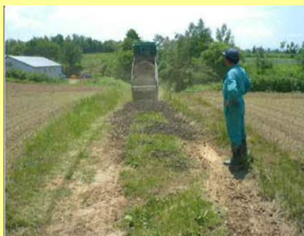
農道の補修・更新
