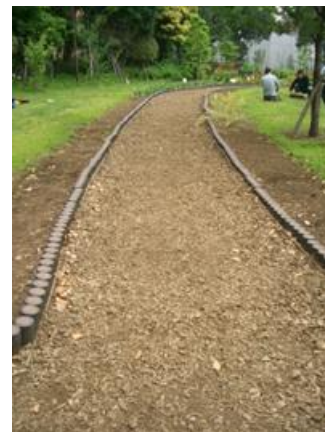
舗装材としての活用事例
