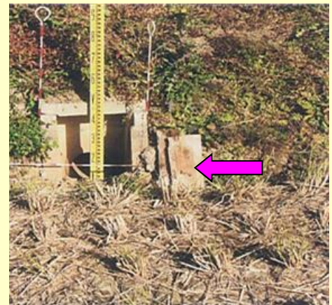
排水調整板設置状況
