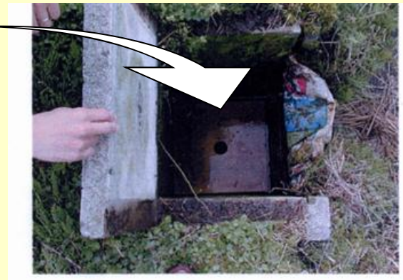
排水調整板設置状況
