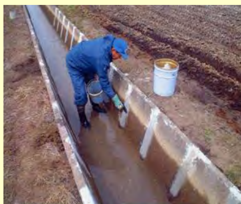
目地詰め作業
