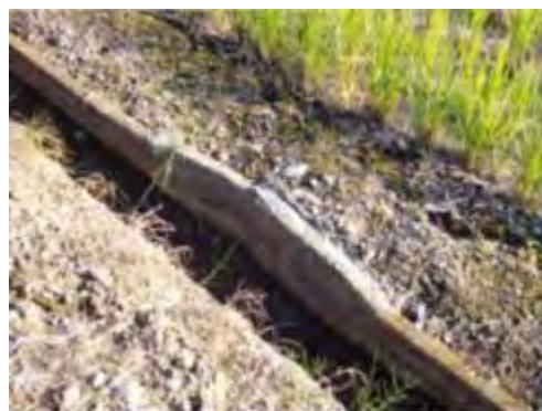
改修したU字溝
