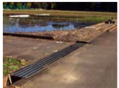
コンクリート蓋とグレーチング
