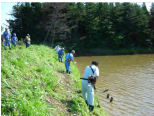
ため池堤体の草刈り
