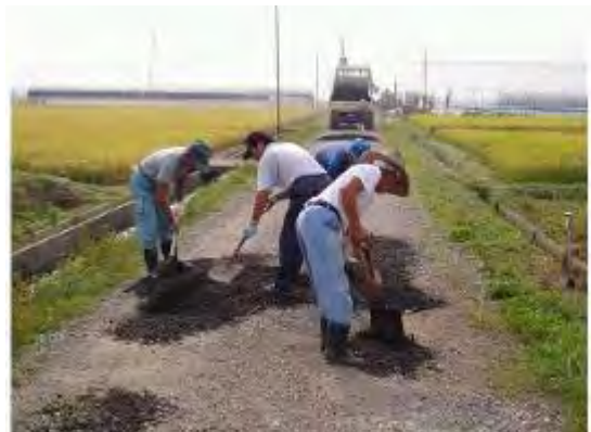
共同作業による砂利の敷き均し
