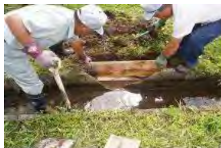
U字溝の改修作業
