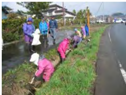
側溝の泥上げ
