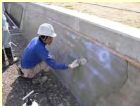
コーティング作業の状況
