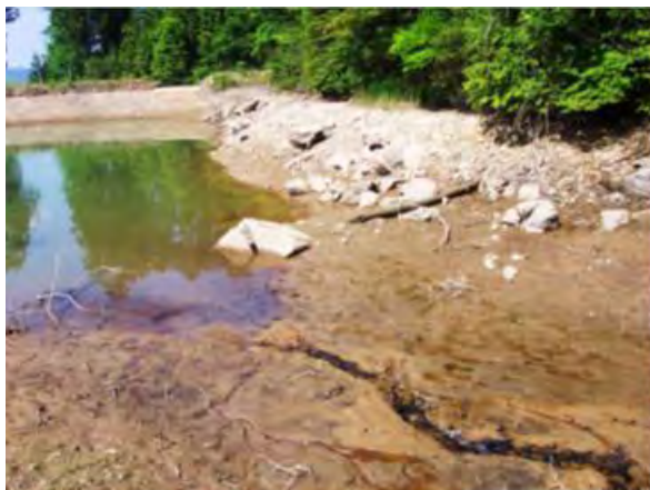
ため池に流入した土砂
