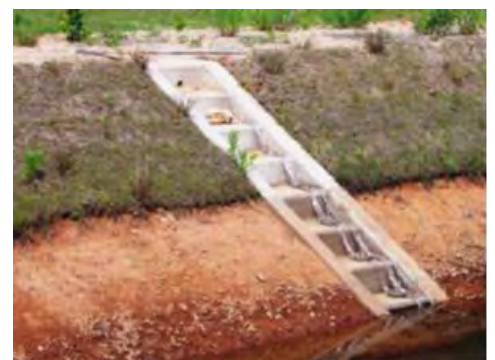
斜樋と取水栓（コンクリート製品）
