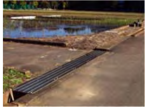
コンクリート蓋とグレーチング
