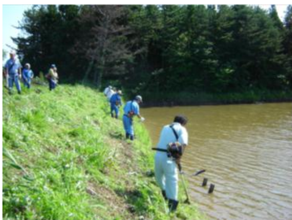
ため池堤体の草刈り
