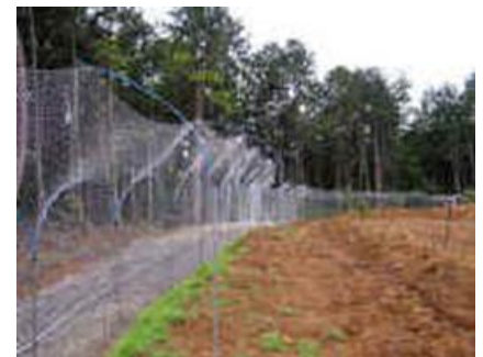
防護柵設置状況
