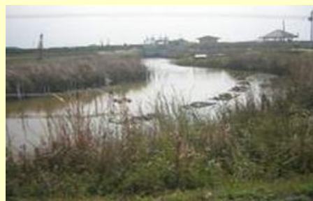
浄化池の状況
