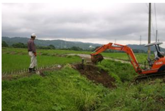
農用地法面の補修
