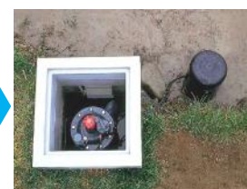
給水栓の自動化へ改良
