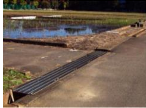
コンクリート蓋とグレーチング
