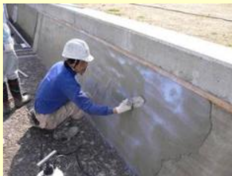
コーティング作業の状況
