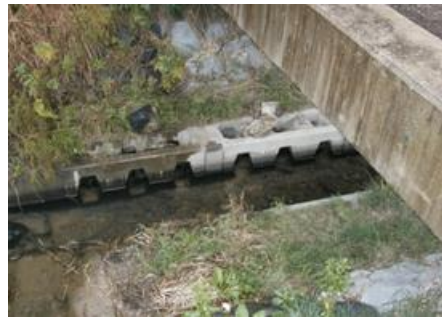
多孔コンクリート護岸
