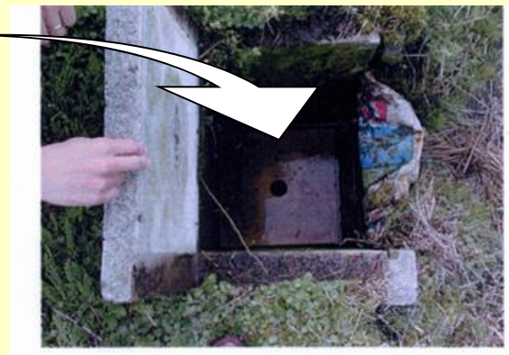
排水調整板設置状況
