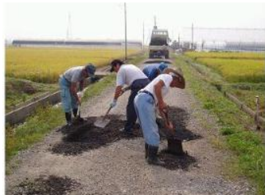
共同作業による砂利の敷き均し
