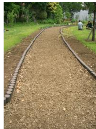
舗装材としての活用事例
