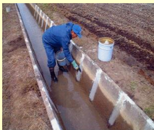
目地詰め作業
