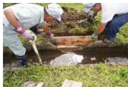
U字溝の改修作業
