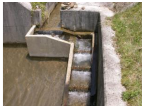
段差解消水路
