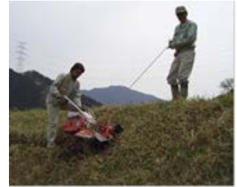
小段設置状況（掘削）
