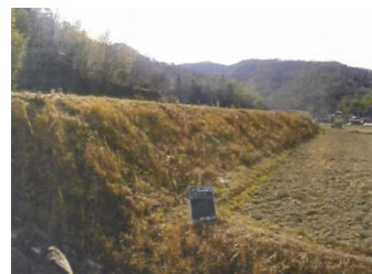
高低差のある畦畔法面
