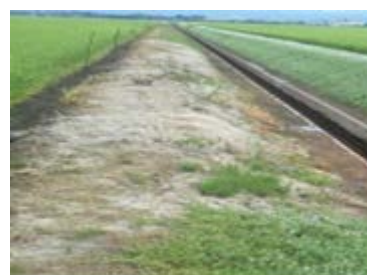
景観悪化の状況
