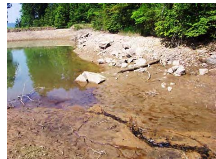
土砂堆積状況
