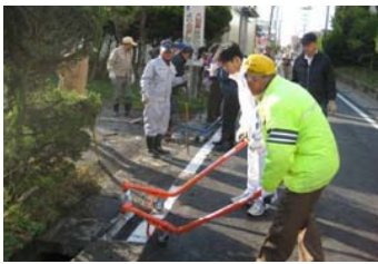
コンクリート蓋設置例
