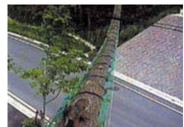
橋梁設置例 (出典：清水建設)
