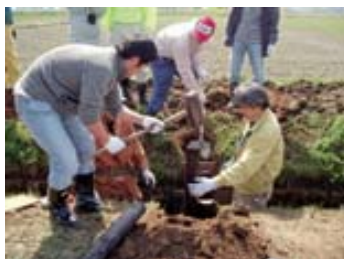
魚道の設置状況
