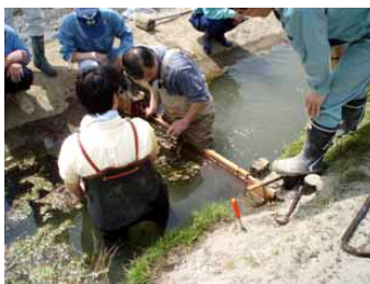
魚道の設置状況（堰板の設置）
