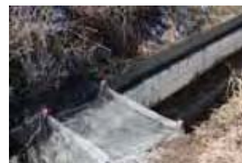
ネット設置例
