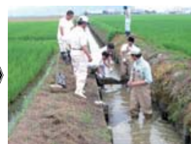
堰板撤去 (6月下旬頃)
