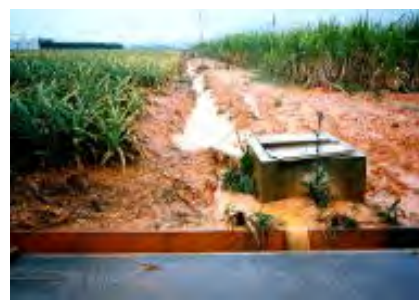
土砂の流出状況
