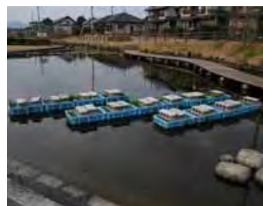
木炭浄化（接触酸化法の一つ）
