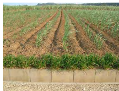
グリーンベルトの設置
