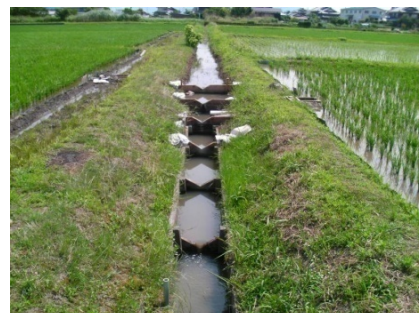
水路魚道（排水路堰上施設）
