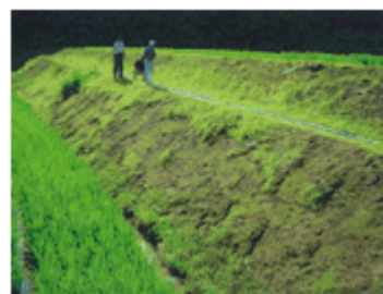
小段が設置されている法面
