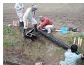
接続・固定状況
