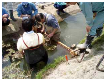
魚道の設置状況（堰板の設置）
