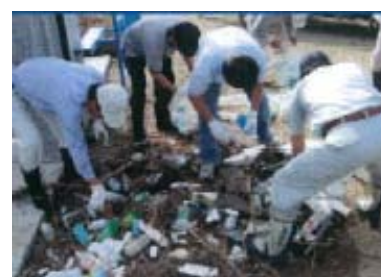
ゴミ・土砂の除去状況
