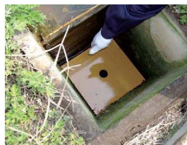
水位調整板の設置
