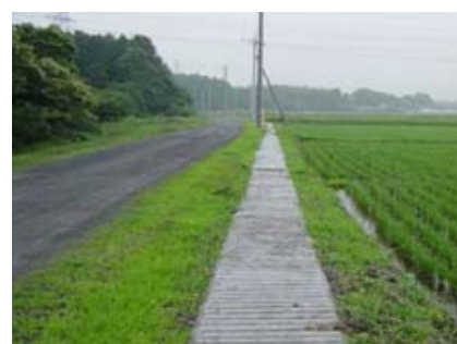
水路へのコンクリート蓋の設置
