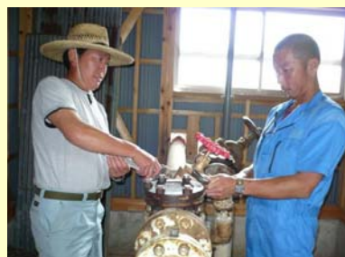
ポンプの点検状況
