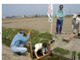
代掻き前の堰板設置 (4月頃)
