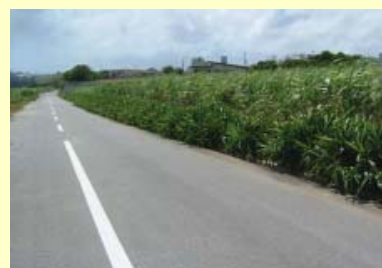
グリーンベルト設置
