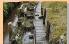
■ 水田魚道の設置
