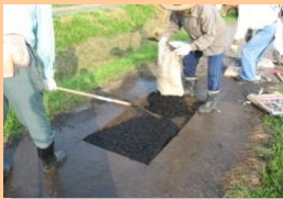
■ 農道舗装の補修
