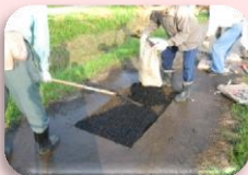
農道舗装の補修
