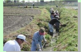
■ 水路の保全管理
