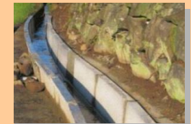
■ 素掘り水路からコンクリート水路への更新
