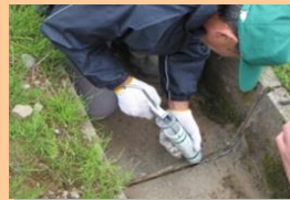
■ 水路の老朽化箇所の補修
