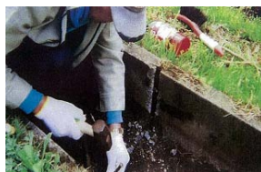
水路の目地詰め作業
