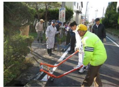
水路蓋の設置 (専用器具使用)
