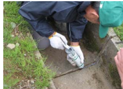
シーリング材充填
