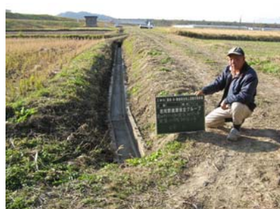
土側溝をコンクリート側溝に更新
