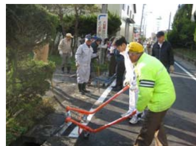
水路蓋の設置 (専用器具使用)
