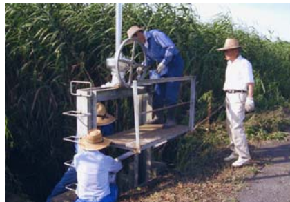
ゲートの点検
