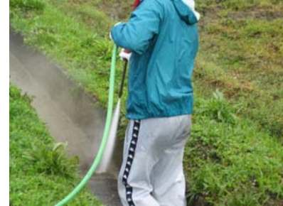
高圧洗浄機による 水路内の清掃
