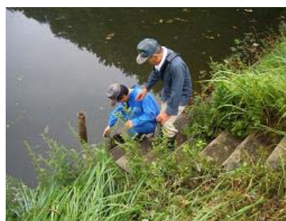
取水施設の点検
