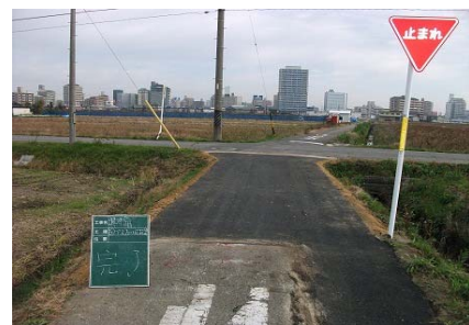
アスファルト舗装の打換え
