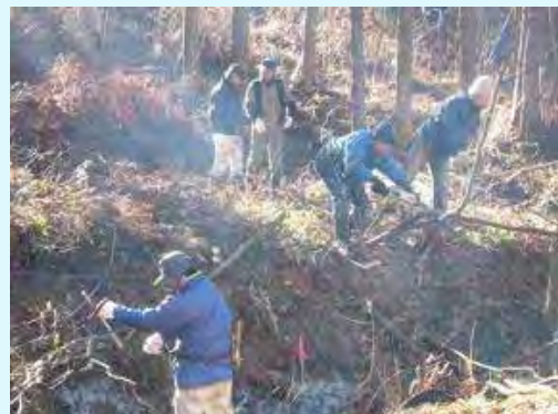
遊歩道の整備に向けた伐採木の搬出作業
