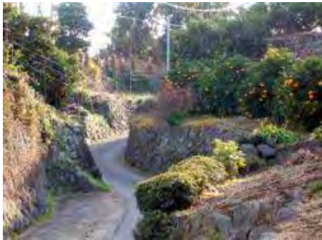
空石積みの水兼農道
