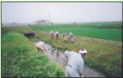
水路の泥上げ (日常の管理)
