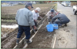
水路の補修 (施設の長寿命化)
