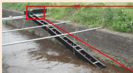
設置した水田魚道
