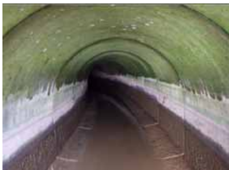
写真 2-3 農業用水路トンネル内部の状況
