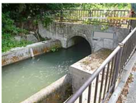
写真 2-1 農業用水路トンネル入口の状況 （かんがい期）
