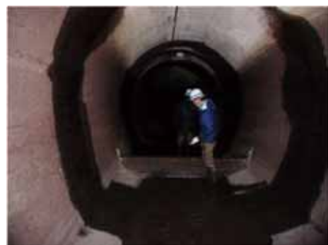
写真 2-4 水路トンネルの管理状況 （目視調査）
