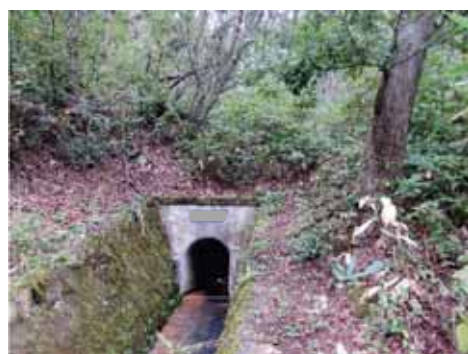
写真 2-2 農業用水路トンネル入口の状況
